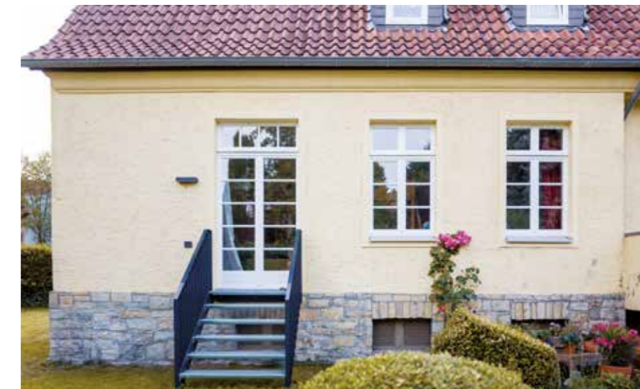
Rentamt Osnabrück: Neue Fenster wurden nach bauzeitlichem Vorbild in den Süd- und Ostfassaden eingebaut.
