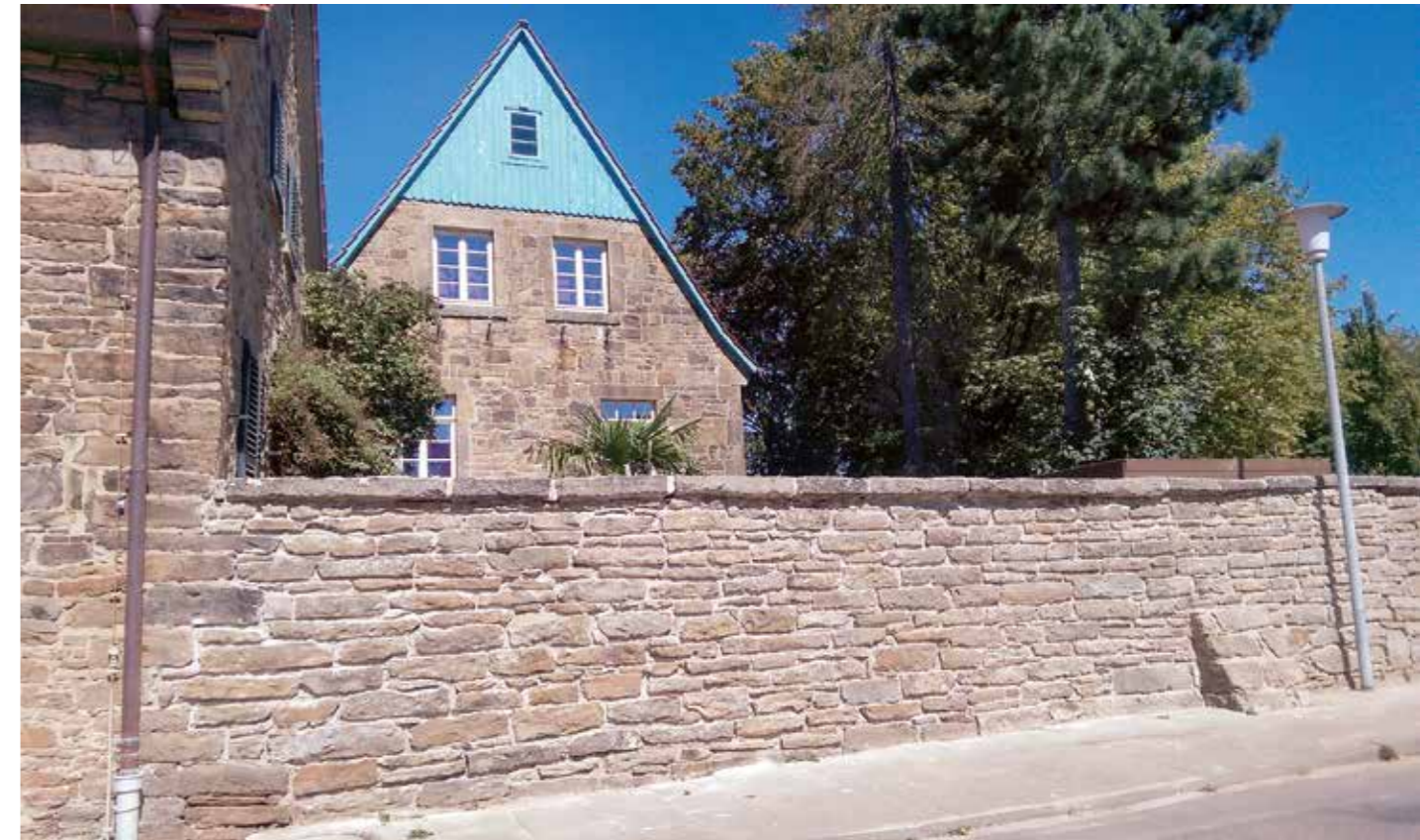
Stift Obernkirchen: Die Mauer um das Stift wurde 2016 saniert.
