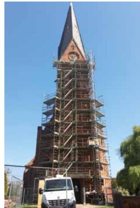
Die eingerüstete ehemalige Stiftskirche in Ramelsloh.
