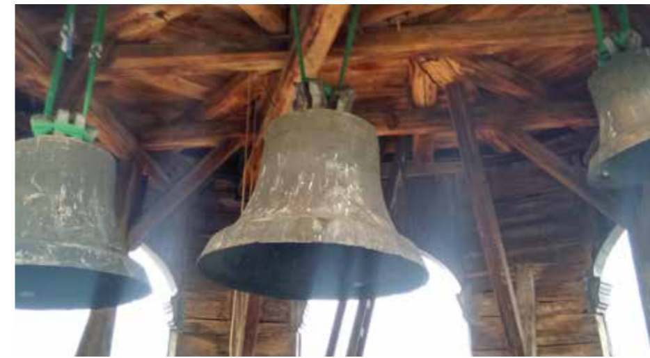
Blick in die Glockenstube von St. Mauritius: Während der Sanierung sind die Glocken provisorisch fixiert.
