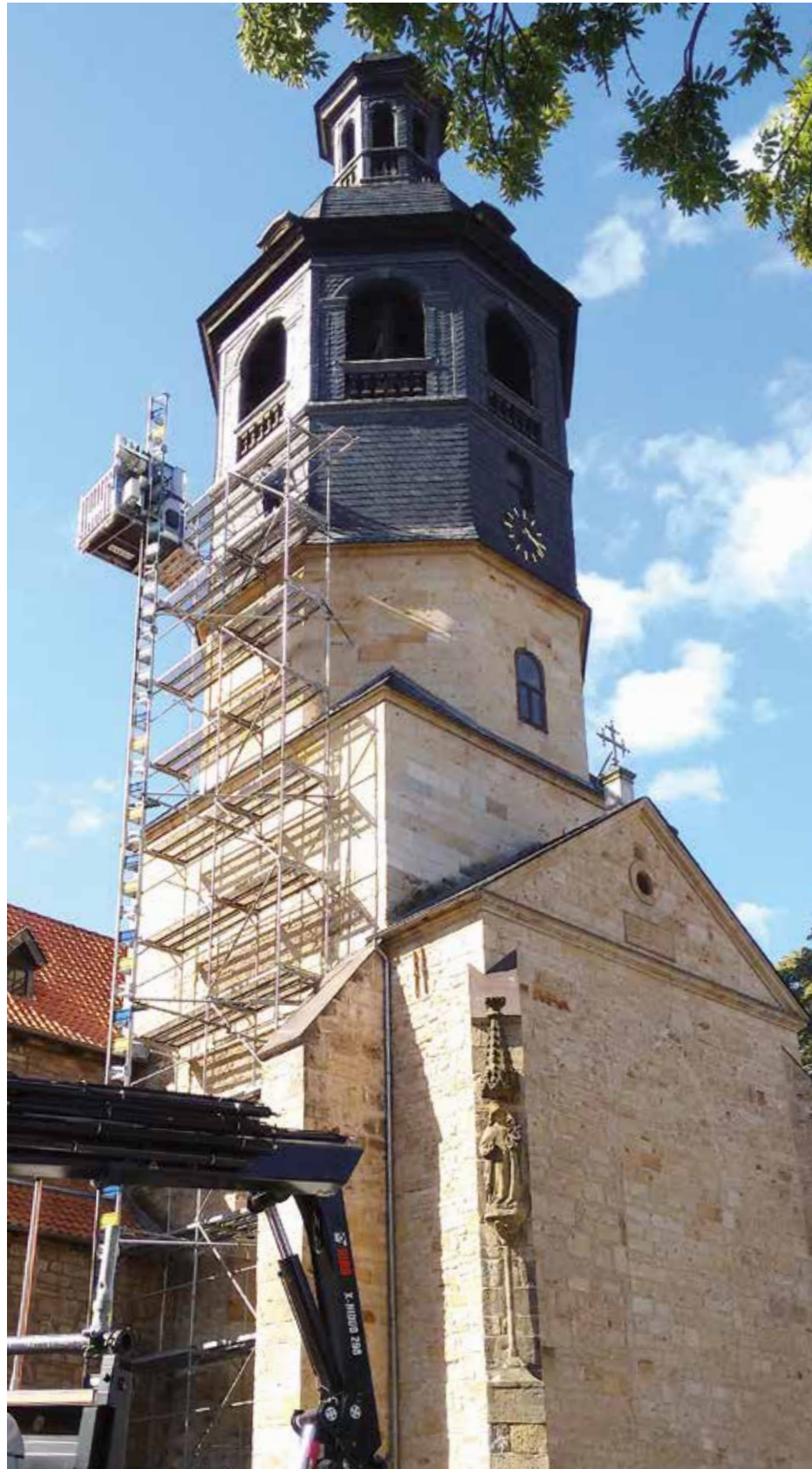
Die ehemalige Stiftskirche St. Mauritius mit Gerüst für den Wiederaufbau des Glockenstuhls.
