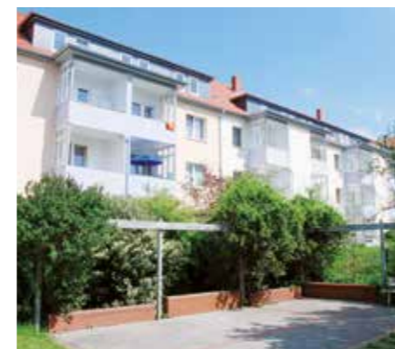
Gebäude auf Erbbaurecht vom Beamten-Wohnungs-Verein in der Hildesheimer Kuckuckstraße.
