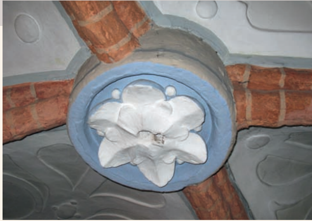
Gewölbeschlussstein und Gewölberippen vor der Restaurierung
