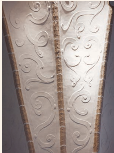
Stuckornament des Gewölbes nach der Restaurierung
