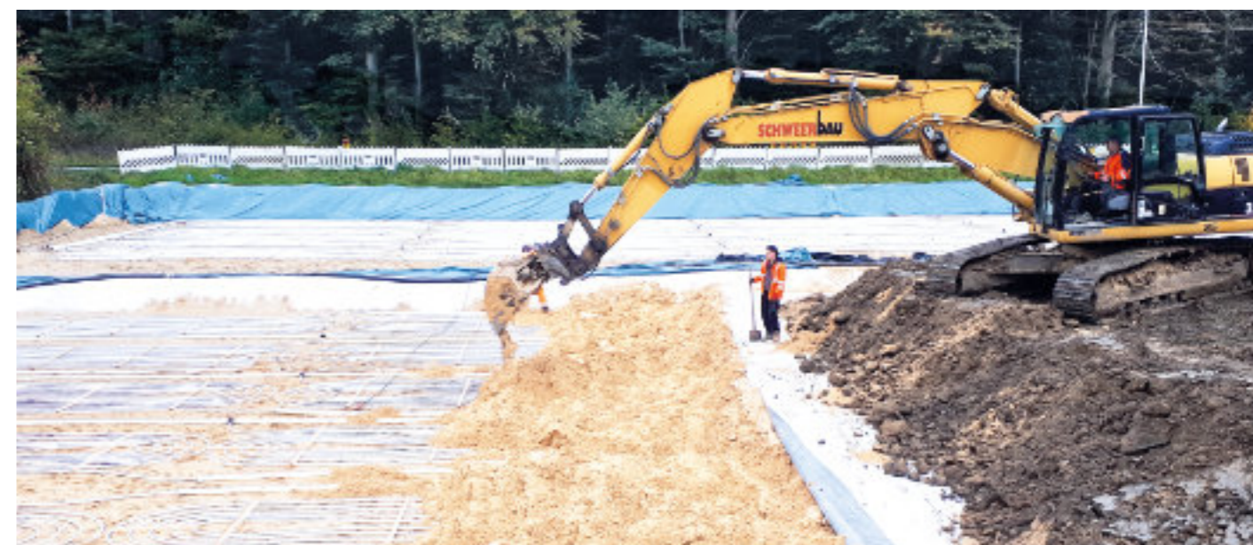
Verlegung der Kollektoren vor Baubeginn in Auhagen.
