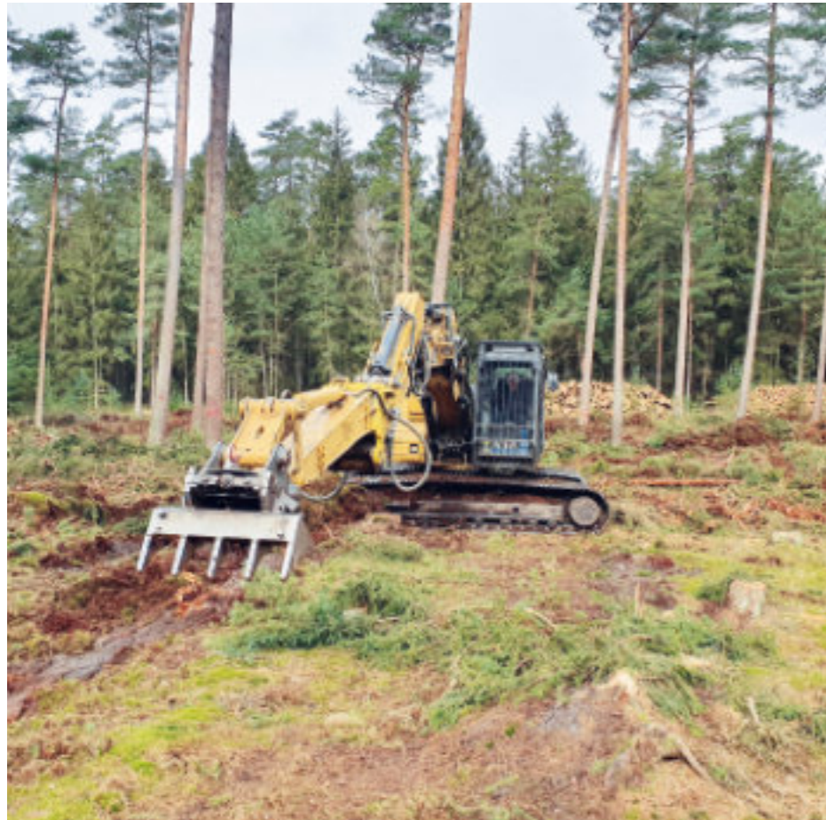
Ein Kettenbagger im Einsatz, der den Waldboden auf die Pflanzung von Jungbäumen vorbereitet, indem er Moose und anderen Bewuchs entfernt. Foto: Sebastian Moitje/Klosterforsten
