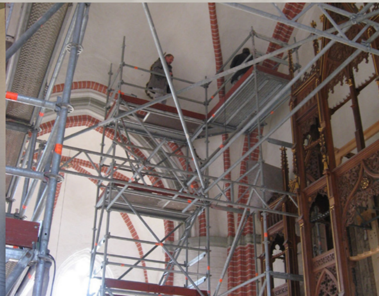
Mit einem Gerüst wurde der historische Orgelprospekt angehoben, um das Tragwerk der Orgelempore für das höhere Gewicht der neuen Schuke-Orgel zu stabilisieren. Foto: Klosterkammer Hannover
