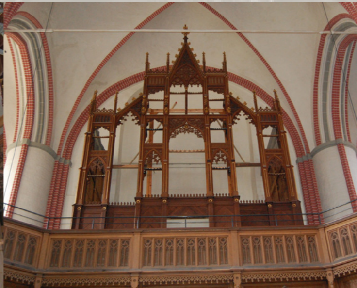
Das historische Furtwängler-Gehäuse nach dem vollständigen Ausbau des Orgelwerkes Foto: Caroline Mennrich/Vögelsen
