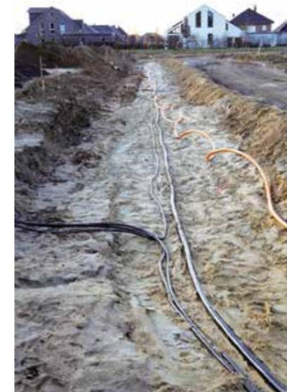
Tiefbauarbeiten: Momentan verlegen die Stadtwerke Gas-, Strom- und Wasserleitungen auf dem Gelände.
