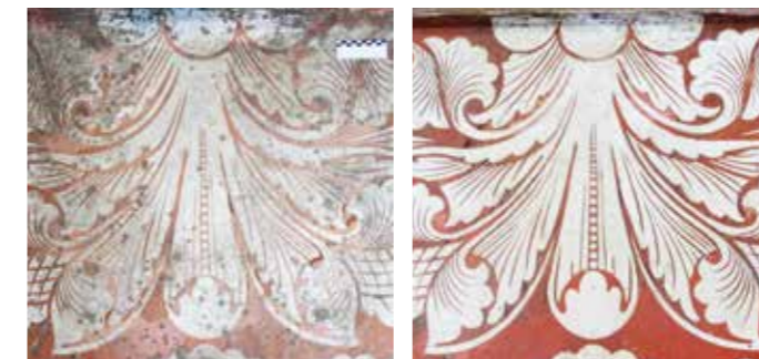
Deutliche Veränderung: Das Bild links zeigt einen Ausschnitt des Chorbodens vor der Reinigung. Das Foto rechts wurde danach aufgenommen.
