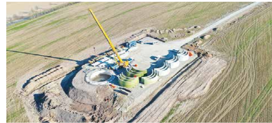
Der Windpark Mariengarten in der Bauphase im März 2019.
