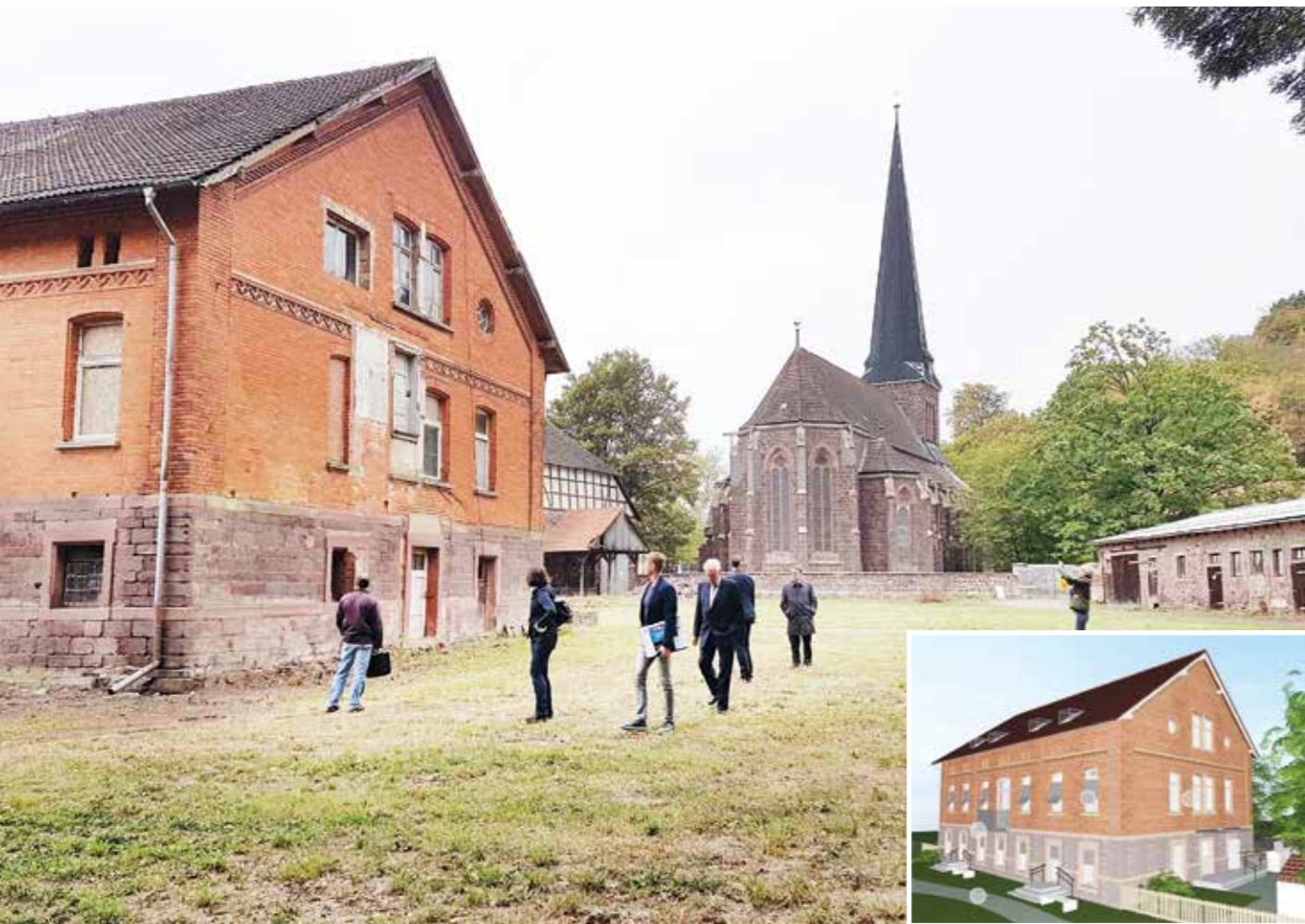
Stift Ilfeld: Das ehemalige Verwalterhaus wird denkmalgerecht zu einer Kindertagesstätte umgeplant. Fotos: Dr. Tim Wameling, Architekturbüro Flaggmeyer (Nordhausen)
