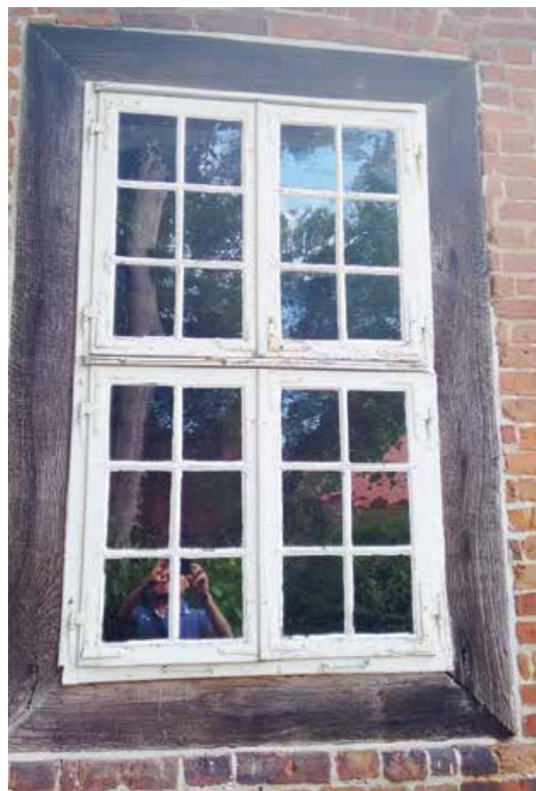
Fenster aus dem 19. Jahrhundert mit den originalen Gläsern in Walsrode. Foto: Christian Griebner
