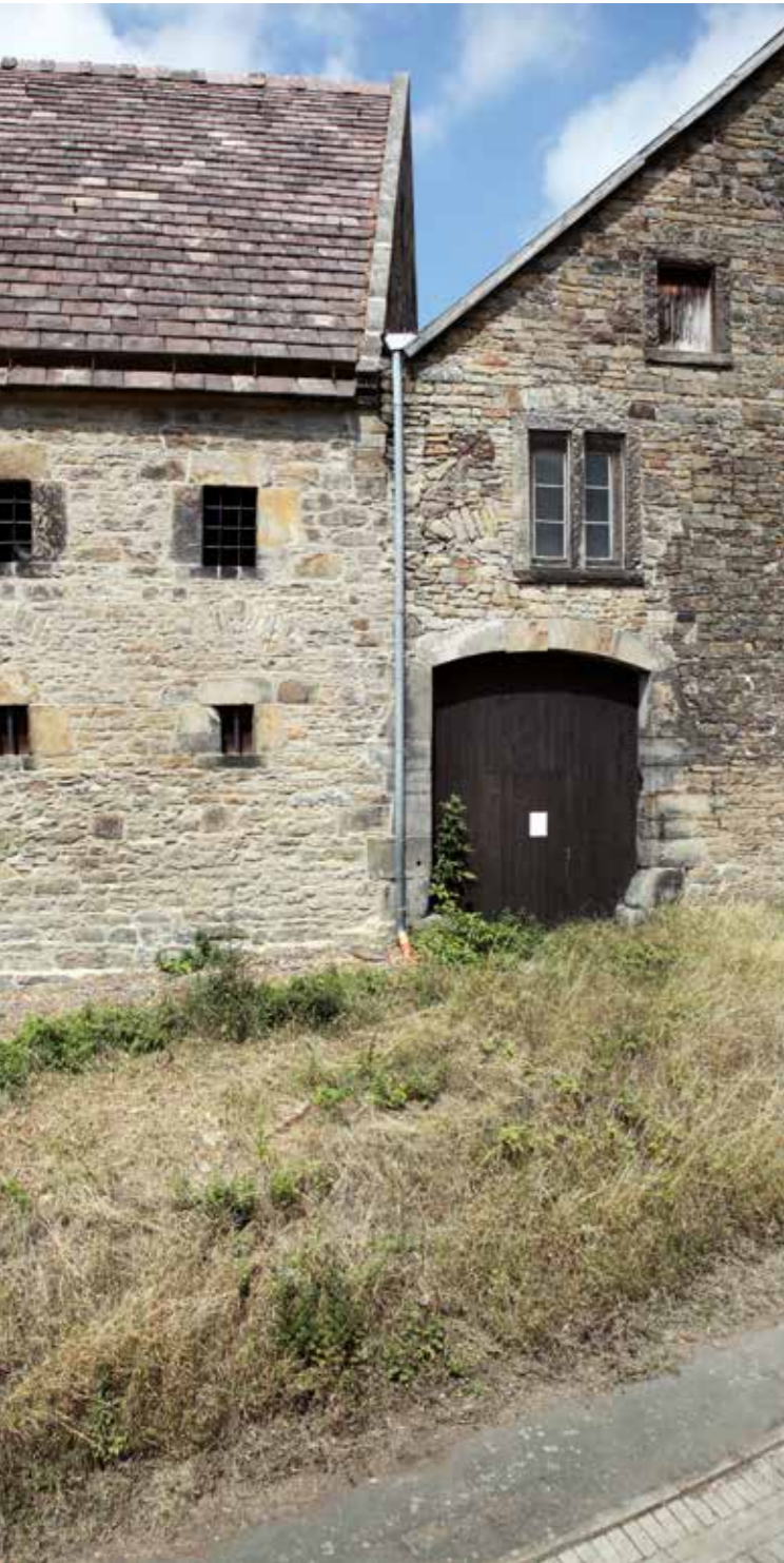
Der Schafstall auf dem Gelände des Stifts Obernkirchen wurde 2018 unter fachlicher Leitung der Abteilung Bau- und Kunstpflege restauriert. Foto: Micha Neugebauer
