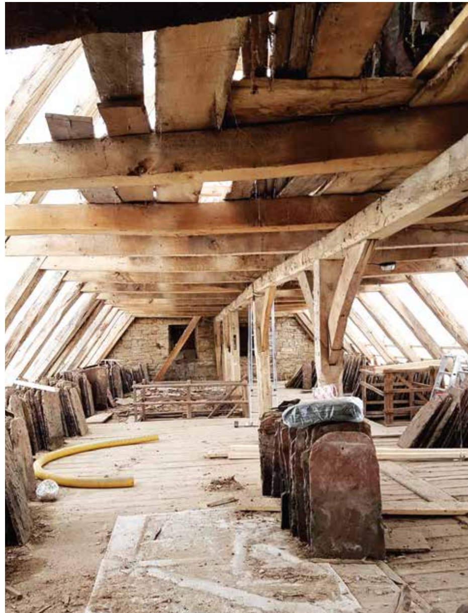
Die historischen Sollingplatten der Dachdeckung wurden am Schafstall im Stift Obernkirchen geborgen, um sie später erneut verwenden zu können. Foto: Dr. Tim Wameling
