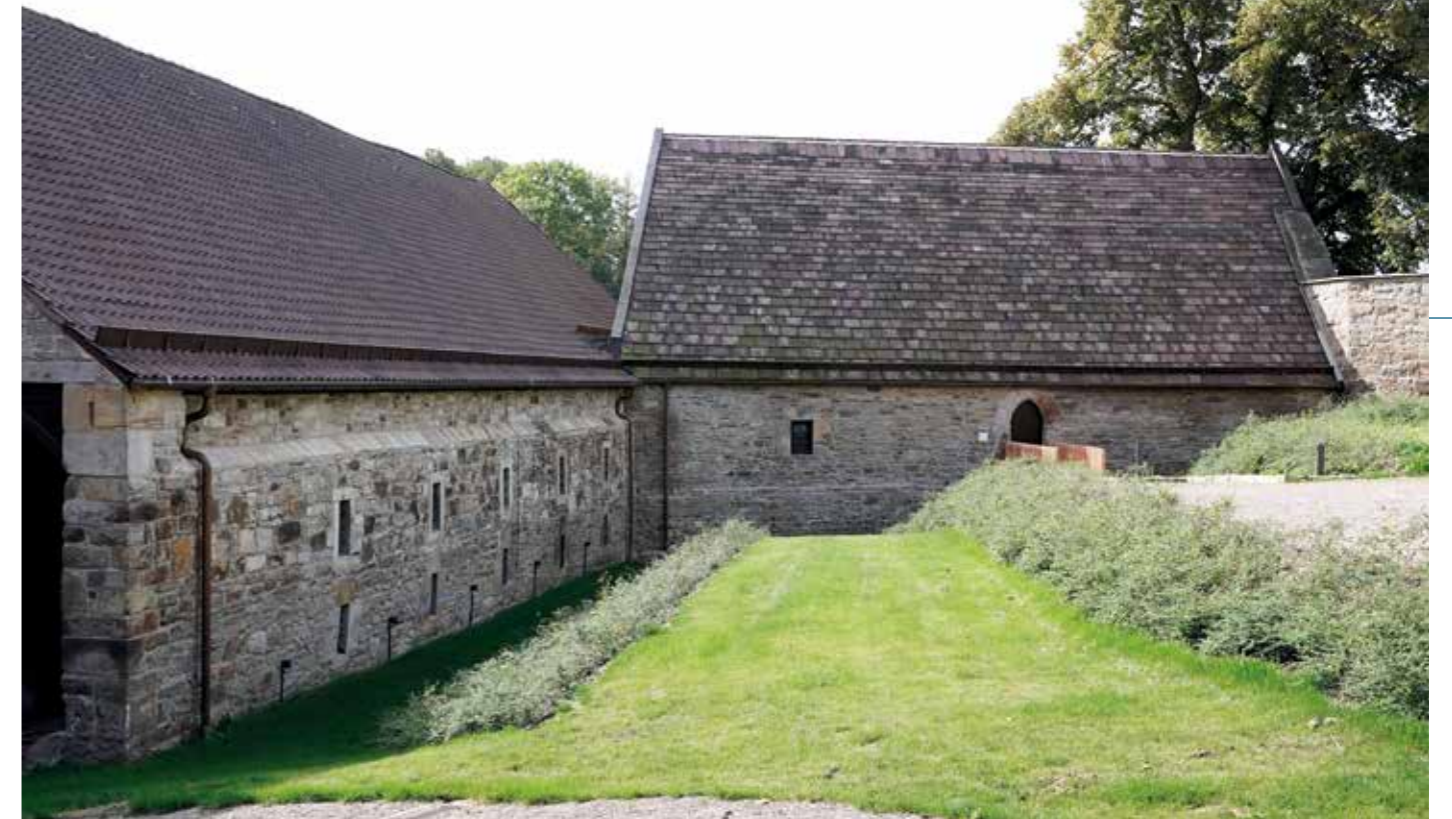
Nach der Sanierung: Der Schafstall im Stift Obernkirchen, links liegt der Zehntscheunengang.
